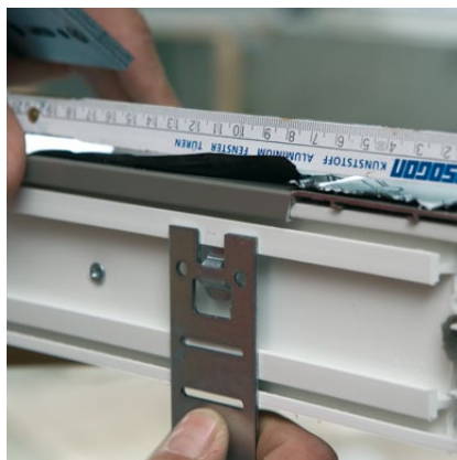
6. Kotvení Provedeme montáž kotevních plechů.
