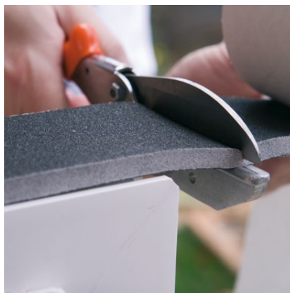
6. Zkrácení pásky Páska se zkrátí nožem nebo jiným ostřím nástrojem.
