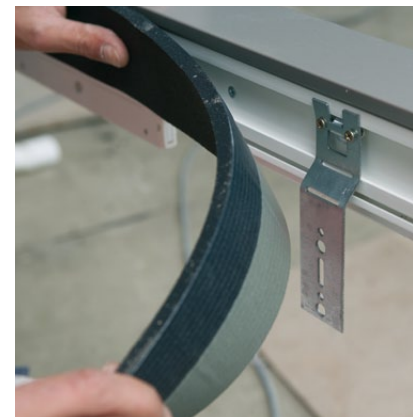
4. Pozor na kotvení V případě plánovaného kotvení okna kotevními plechy musí být tyto plechy již instalovány.
