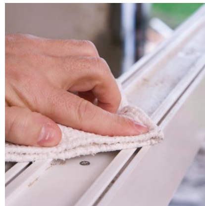
3. Očištění rámu Očistíme a odmastíme okenní rám.
