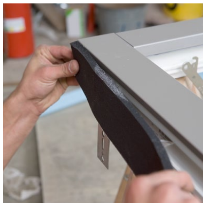
5. Páska na rám Páska se aplikuje na očištěný rám okna.
