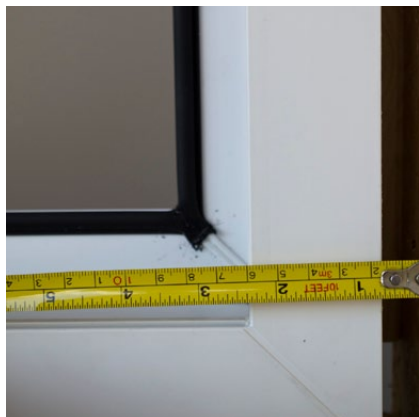
1. Vyměření Změříme velikost připojovací spáry (prostor mezi rámem okna a ostěním).
