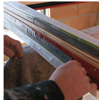
4. Lepení fólie Nalepíme fólii na rám okna z interiérové a exteriérové strany. Fólie jsou opatřeny samolepicím proužkem.
