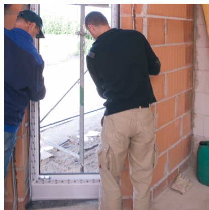
7. Osazení okna Následně vsadíme okno do otvoru, vyrovnáme a vyklínujeme.
