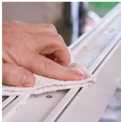
3. Očištění rámu Očistíme a odmastíme okenní rám.
